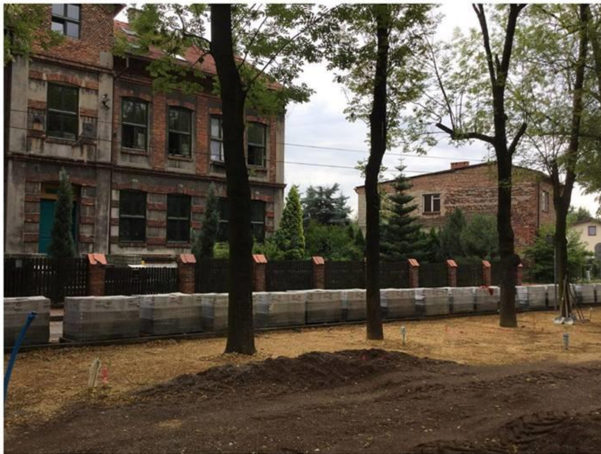
STAN ISTNIEJĄCY - SZKOŁA,
