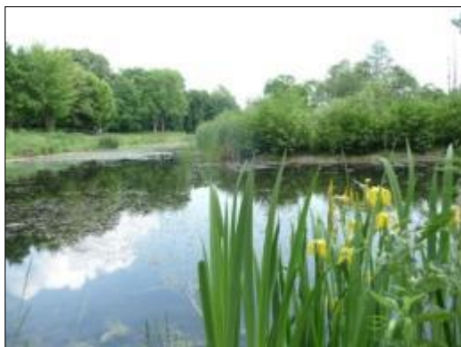
Zbiornik fitoremediacyjny (zbudowany w 2006)
