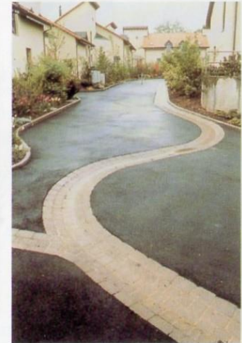
Rysunek 2-14 Otwarte koryta do uspokojenia ruchu drogowego
